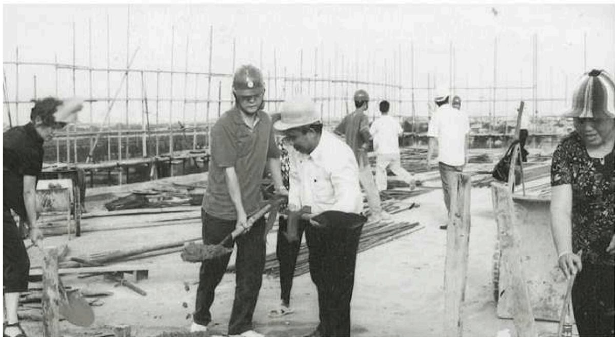
顶固首个厂房建设中林新达到现场帮忙
